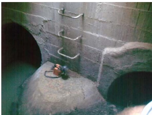
Passage sous la voie SNCF
