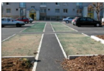
Exemple de parking réservoir à Albi
