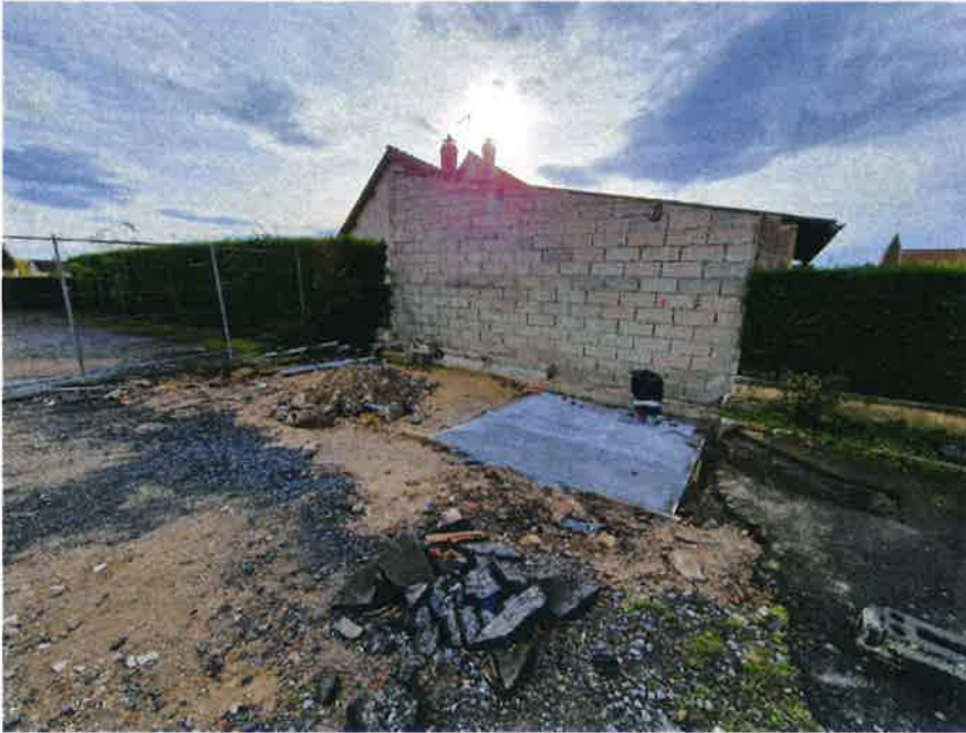
e) Travaux de VRD
